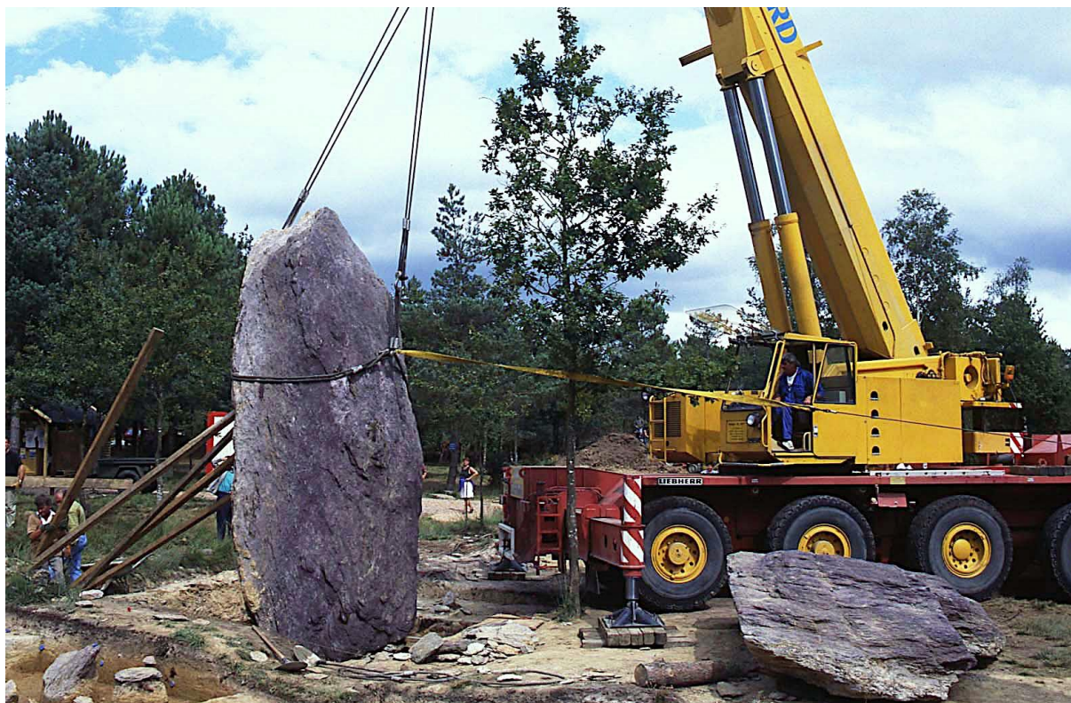
Aucun problème pour le grutier qui a la puissance de son engin pour lui. Photo Gaby Le Cam
